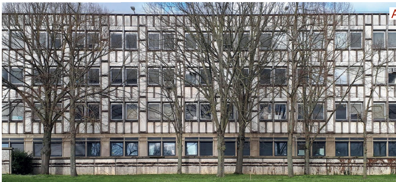
Bâtiment 4 - la façade sud - l'ordonnement décliné sur le principe d'élément préfabriqué et modulaire
