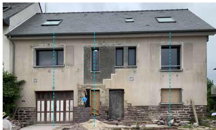
Modification des percements : élargissement des baies, transformation de la porte en fenêtre, création de baies à rez-de-chaussée.
