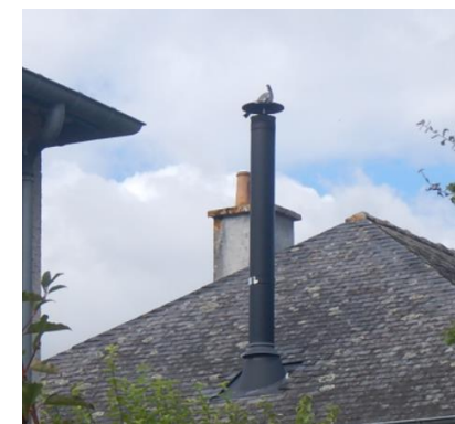
Exemples de conduit de poêle ou cheminée, en inox brillant ou en noir mat. Préférer le noir mat.
