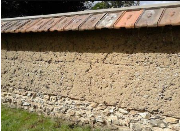
Mur en terre sur solin en Pierre avec couvrement en tuile terre cuite.
