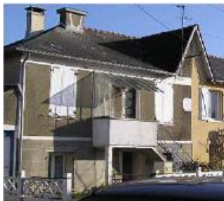
Les façades étaient marquées de bandeaux horizontaux marquant les différents niveaux. Le soubassement est traité de façon différenciée.
