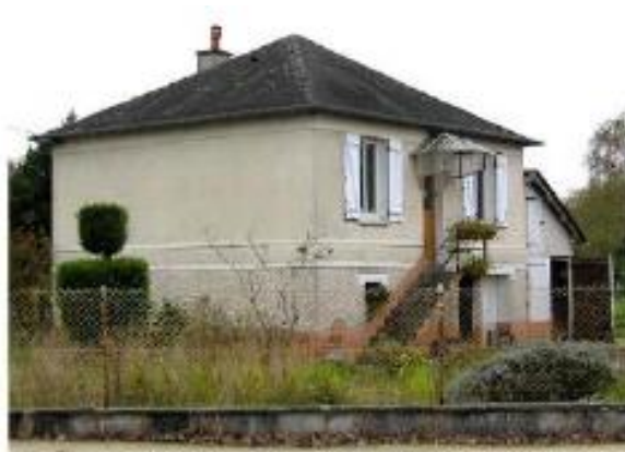
Les façades étaient marquées de bandeaux horizontaux marquant les différents niveaux. Le soubassement est traité de façon différenciée.
