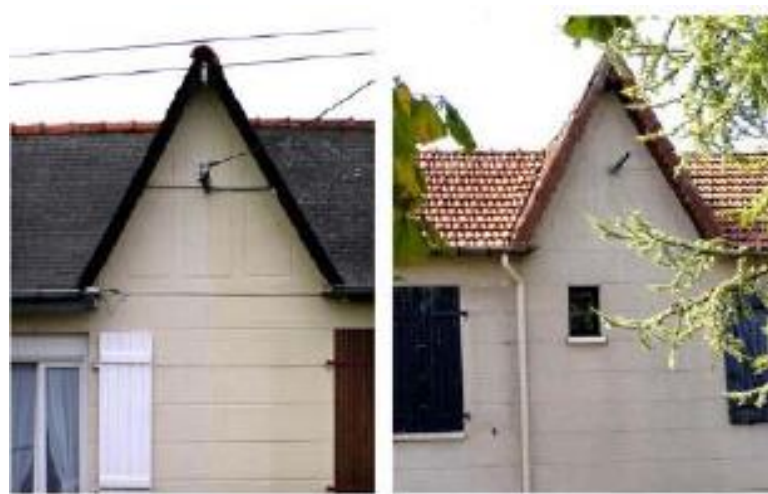
Traces du traitement visible sur quelques frontons : décors en creux et frise de bois découpée et colorée en bordure de toit.
