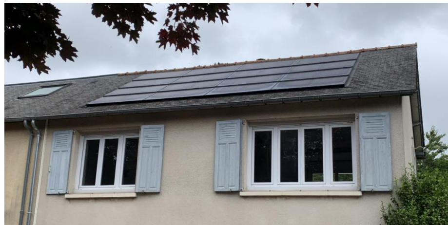
Pose intégrée dans le plan de la toiture permettant de réduire l'impact visuel des panneaux.
