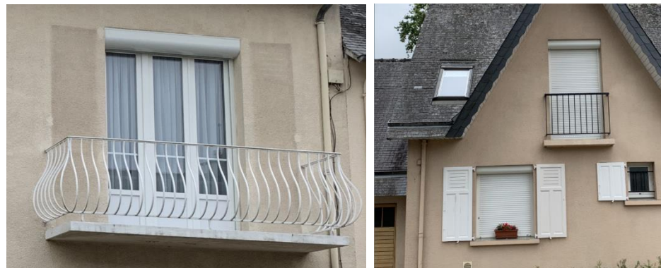
Retrait des volet bois et pose d'un coffre de volet roulant en extérieur, volets roulants fermés en journée : l'ensemble est préjudiciable à la qualité générale de la façade et au paysage urbain.
